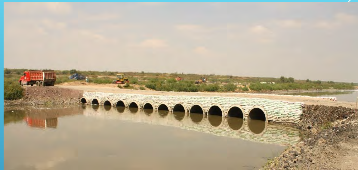
Desazolve del Dren General del Valle
