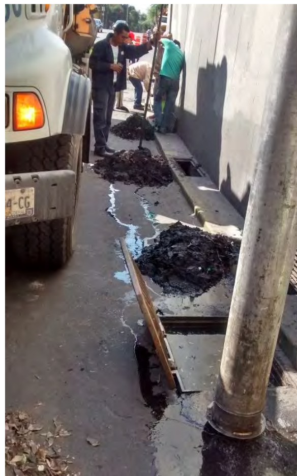
Viaducto Miguel Alemán
